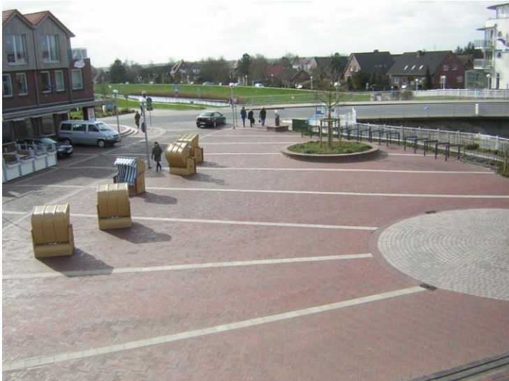
Blick aus Richtung Hafen Bengersiel nach Süden
